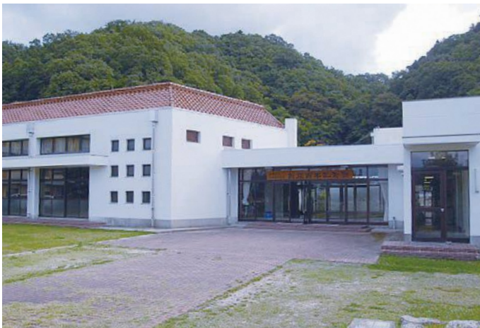
■改修後の同窓会館外観
